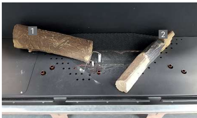
Фото 2: монтаж, этап 1 (без подсветки)
