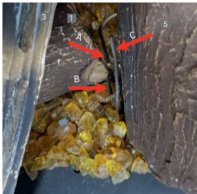
Фото 9: размещение ионизатора (А), розжига (В) и заземления (С). Зазор между ионизатором и розжигом должен составлять от 3 до 7 мм. Убедитесь, что электроды ионизатора и розжига свободны, отсутствует контакт между ними или контакт с керамическими дровами или декоративными материалами.
